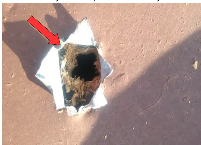
foto/10/ Pohled na přípravu pro zavedení videoskopu
