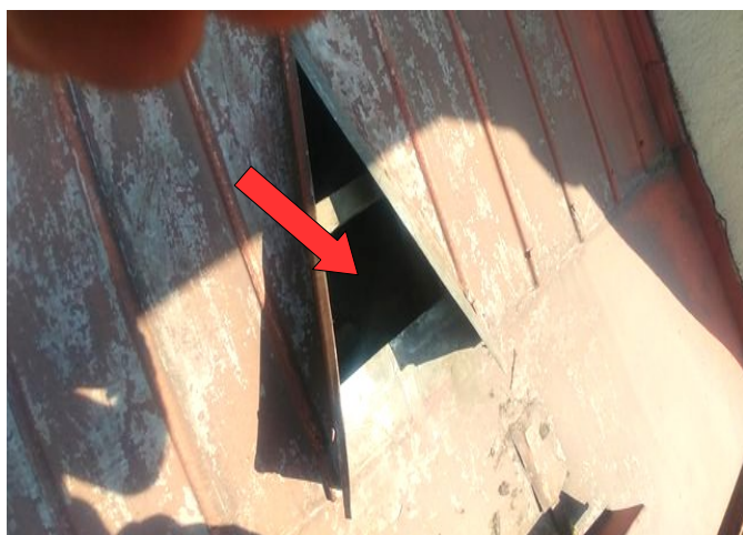
foto/13/ Pohled na rozkrytou střešní krytinu v místě sondy
