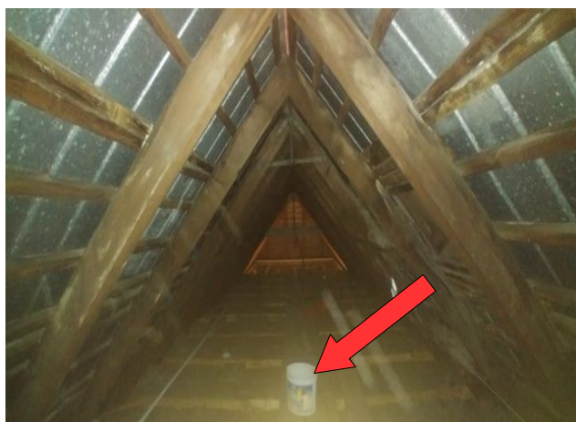
foto /10/ Pohled na půdní prostor s rozestavenými kbelíky pro zachycování vody
