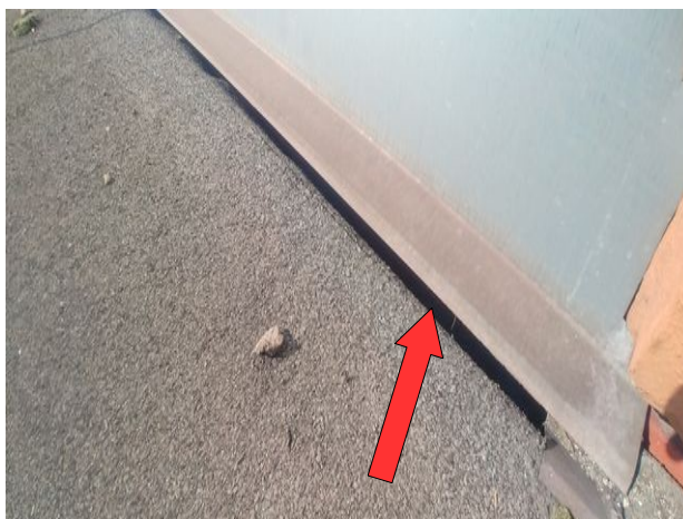
foto /17/ Pohled na netěsné ukončení povlakové hydroizolace
