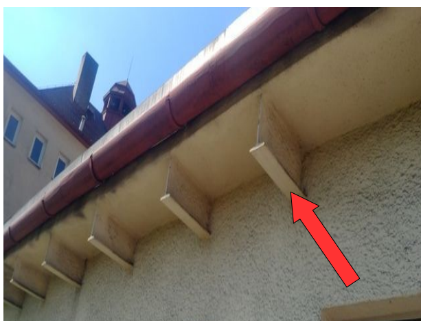
foto /21/ Pohled na prostupující ocelové válcované nosné profily
