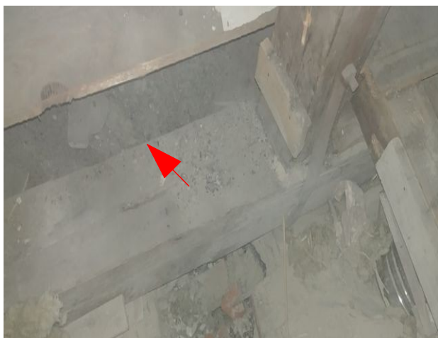
foto/20/ Pohled na místo odběru vzorku S3 – vazný trám
