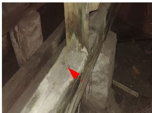
foto/23/ Pohled na místo odběru vzorku S6 - vazný trám
